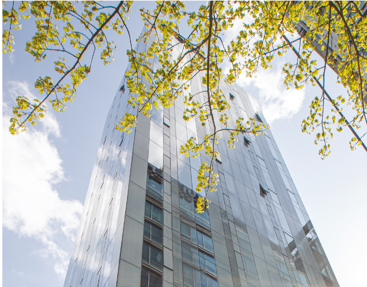
교대역 삼남강재 빌딩 (Location : 서초구 1574-10)
